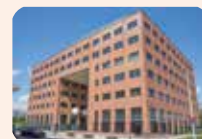
Kabelweg 57 1014 BA Amsterdam
