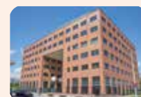
Kabelweg 57 1014 BA Amsterdam
