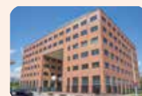
Kabelweg 57 1014 BA Amsterdam
